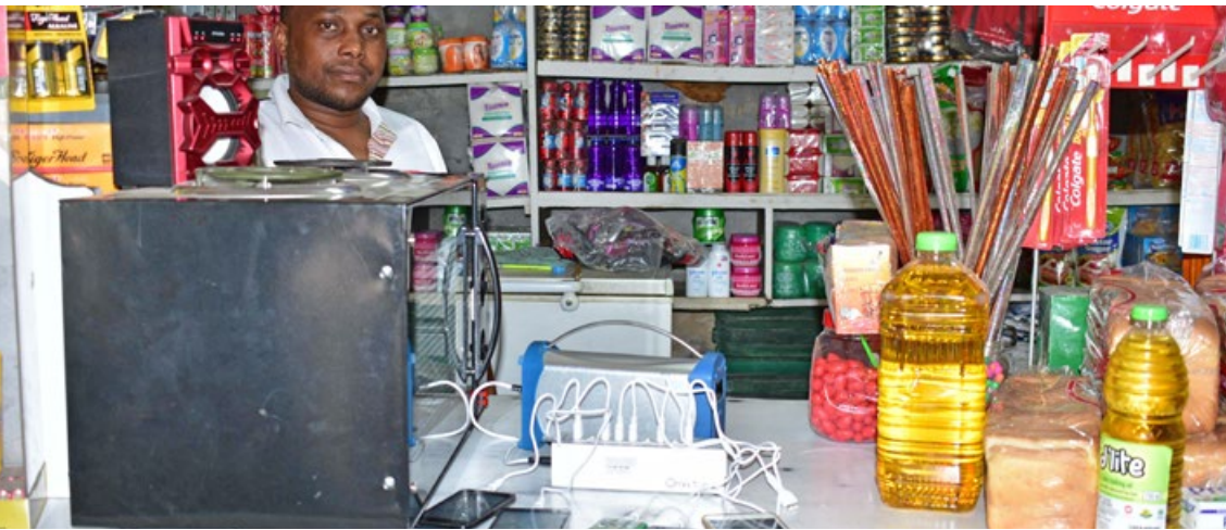
MPower System in einem Kiosk in Sambia
